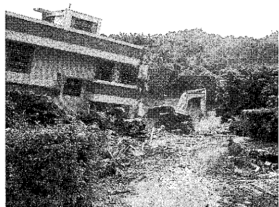
写真-28 車籠埔 断層上盤側家屋の倒壊
