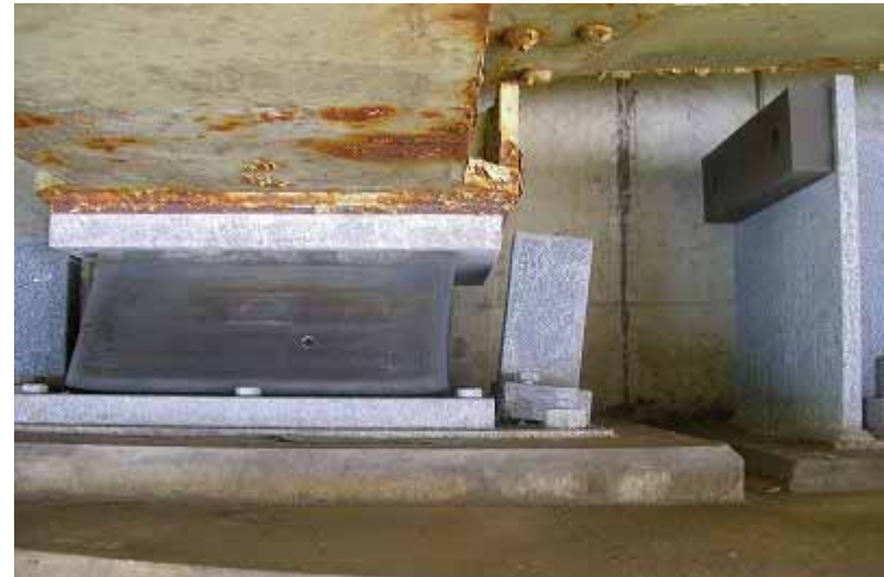
ゴムシュー、橋軸直角方向にも動いている
