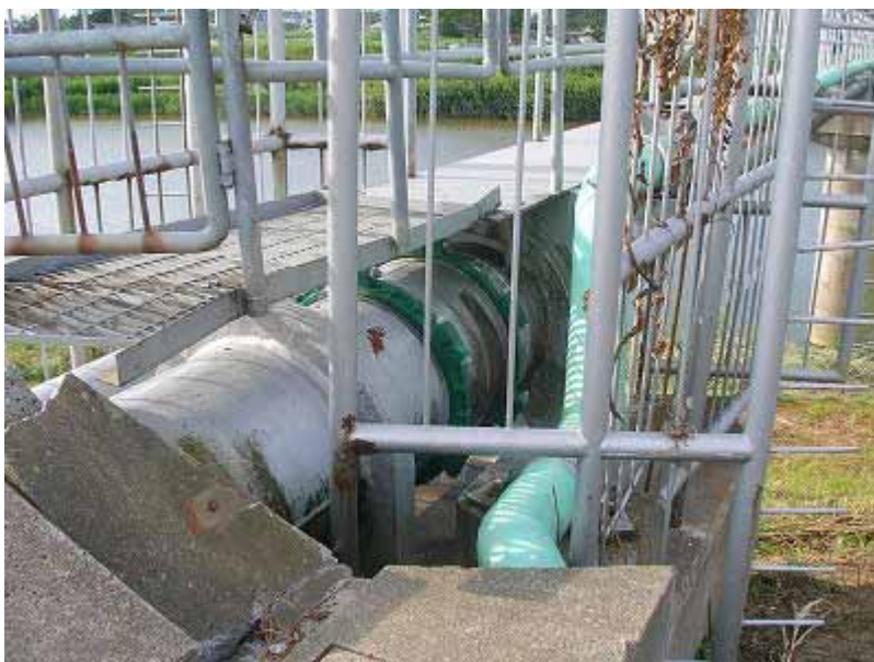
近接する開運橋に仮設された水道管。この手前側は地上仮配管がなされていた。
