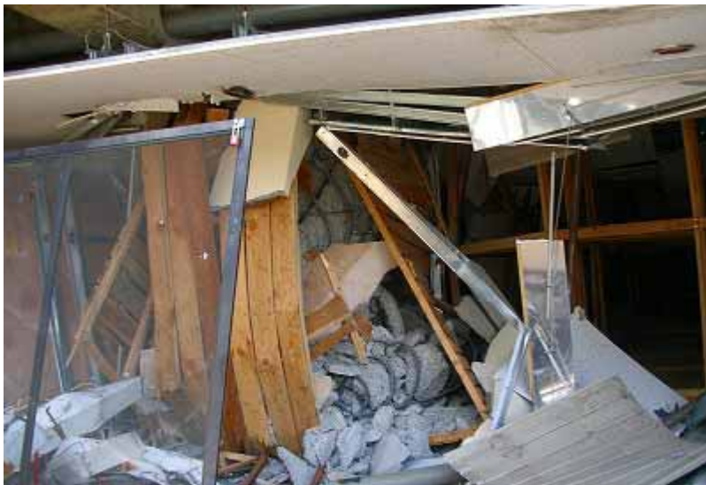
右の建ての物の1階部分。柱は全てこのような状態
