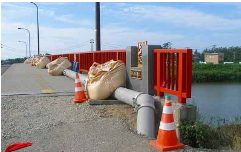
近接する開運橋に仮設された水道管。この手前側は地上仮配管がなされていた。
