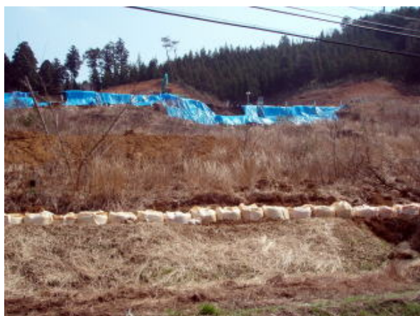
(g)復旧工事の様子
