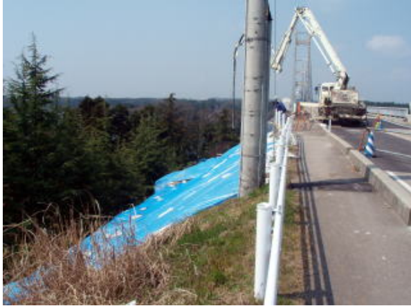
(a)作業車のアームからケーブル（？）が下がっている
