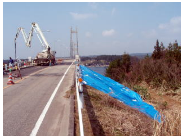
(d) 応急復旧による取付部段差の修復跡と思われる 写真 5.2 ツインブリッジのと
