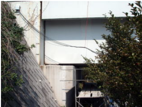
(c)元々、工事中であった様子
