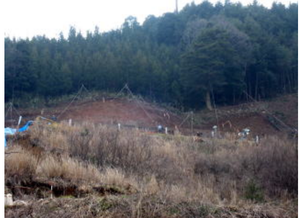
(h)復旧工事の様子
