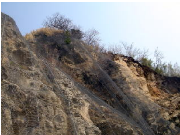
(e)北側からアプローチ
