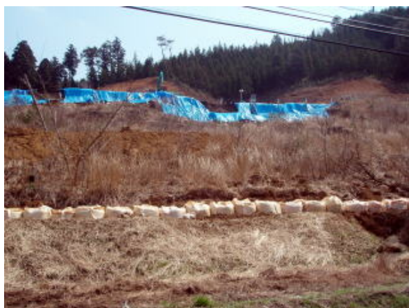
(g)復旧工事の様子
