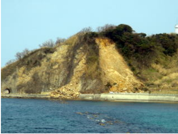
(a)南側からアプローチ
