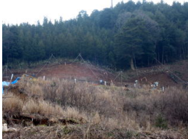
(h)復旧工事の様子
