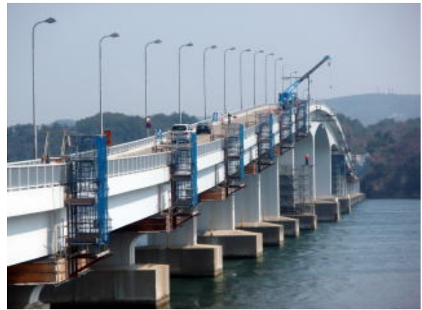
(b)補修工事を行っている
