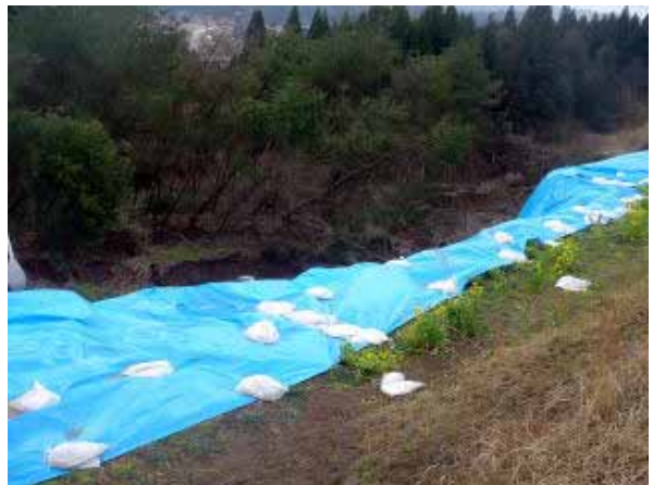
写真 2.4 能登自動車道（横田 IC 付近）における盛土崩壊
