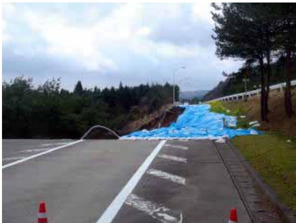
写真 2.4 能登自動車道（横田 IC 付近）における盛土崩壊
