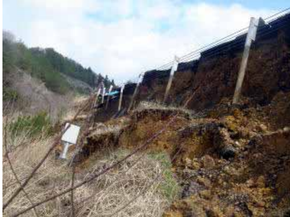
写真 2.3 能登有料道路（豊川橋付近）における盛土崩壊
