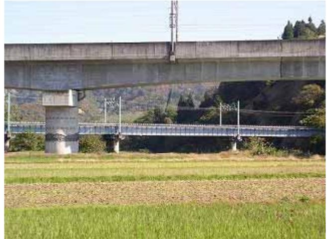
上越新幹線魚野川橋梁(3径間連続PC箱桁橋)。単柱に被害。写真奥は在来線の橋梁。
