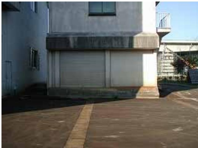
流域下水道竜光ポンプ場の地盤沈下
