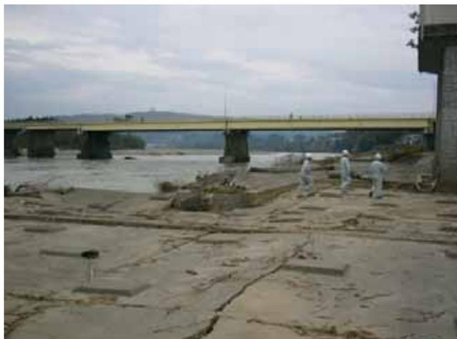
[同左付近 高水敷] 地盤の液状化の影響により高水敷継ぎ手部において段差が生じている。
