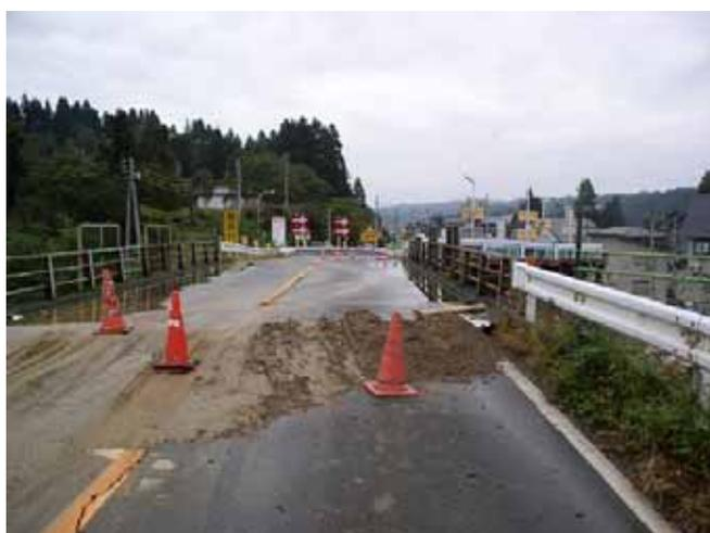
堀之内町-橋台裏の盛土沈下、段差。このような段差はいたるところにあり。ただし橋本体の被害は軽微
