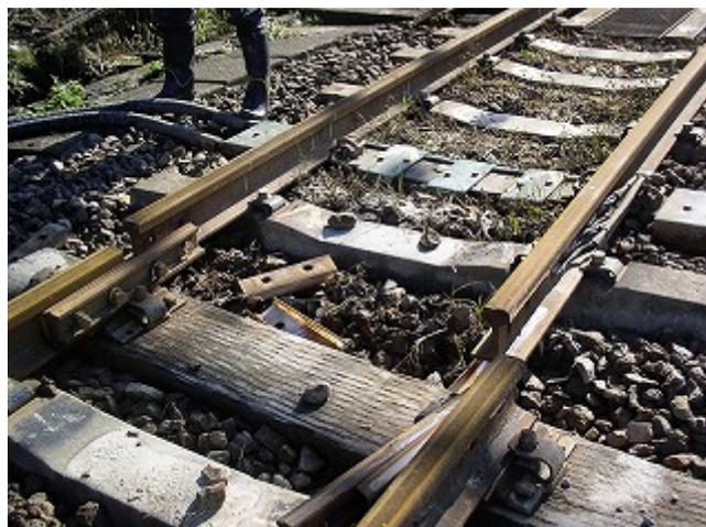
上越線越後川口駅付近のレール継ぎ目。ボルトが飛んでいる。
