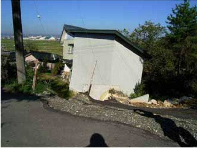
長岡市乙吉町(愛鱗温泉)。道路盛土の被害に巻き込まれ住宅の被害が発生。
