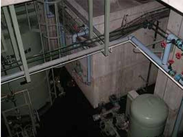
汚泥棟の冠水状況（水位上昇の痕跡）
