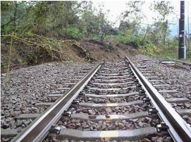
上越線北堀之内駅付近。斜面崩壊で土砂が線路を塞いでいる。
