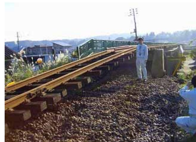
飯山線越後川口駅付近。魚野川に架かる鉄橋取り付け盛土が沈下。
