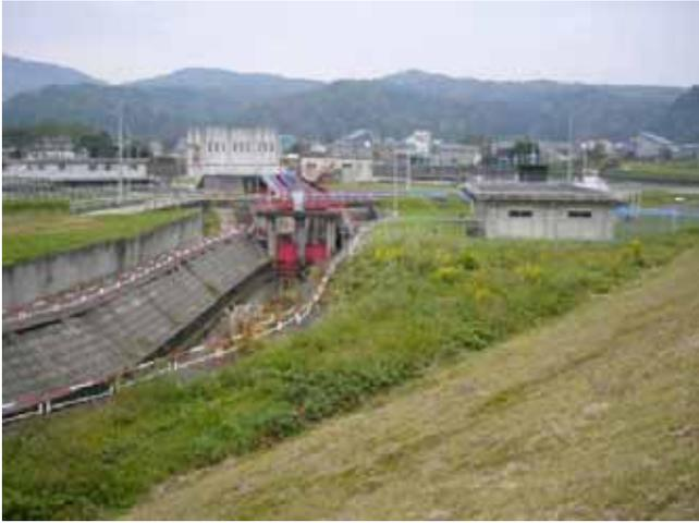
[長岡市 妙見浄水場] 取水を行っていると思われる水路。付近の河川堤防の崩壊により水路の通水機能を阻害。
