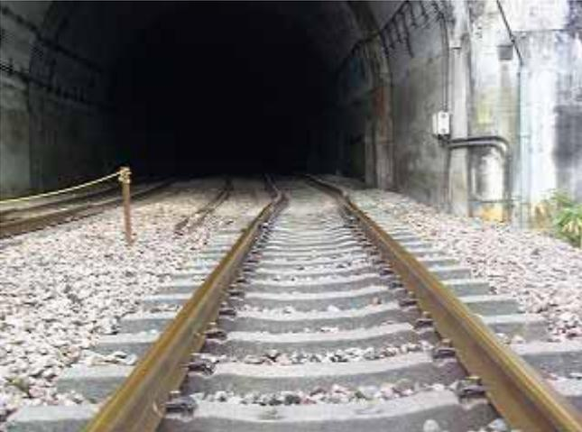
上越線和南津トンネル。手前のコンクリートが写真右側にずれている。レールも変形。
