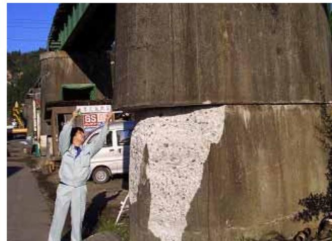
飯山線越後川口駅付近。橋脚のずれ。鉄筋は入っていない模様。
