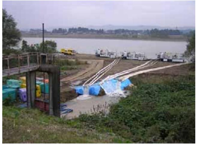
[同左 樋門付近] 取水を行うため信濃川より樋門付近にポンプで圧送し、さらに場内施設に直接ポンプアップしている。
