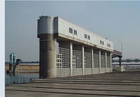
水資源開発公団秋ヶ瀬取水施設(7柱式ラーメン構造)
